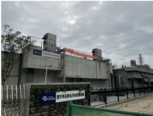
石桥头污水处理设施
