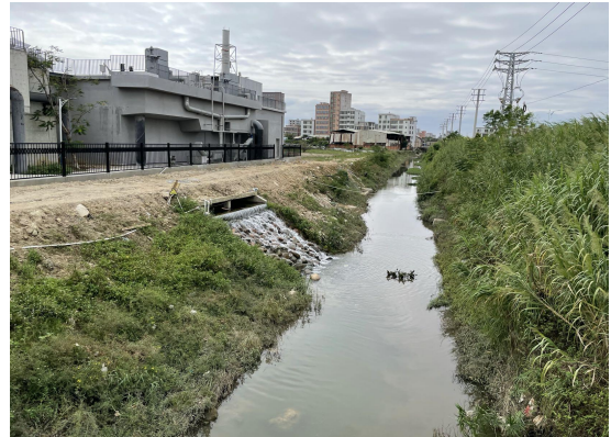
南切流及石桥头污水处理设施排污口
