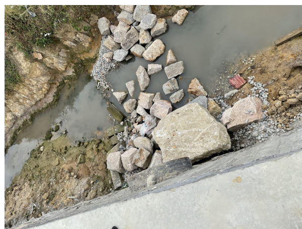
项目东侧石桥头排水渠
