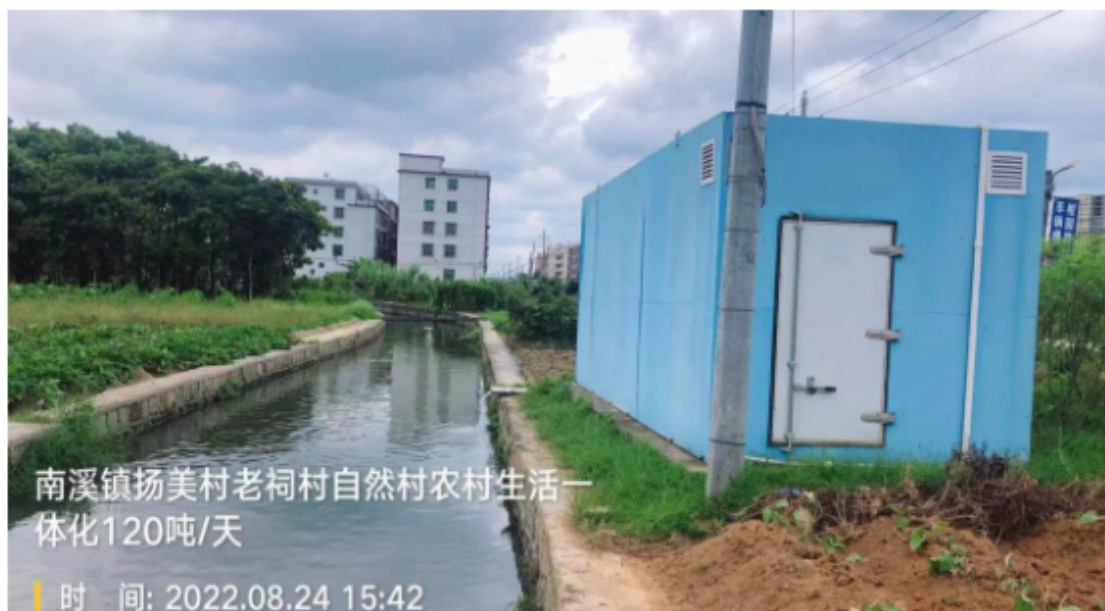
图 6.2-1 本项目依托污水处理设施实景照片
