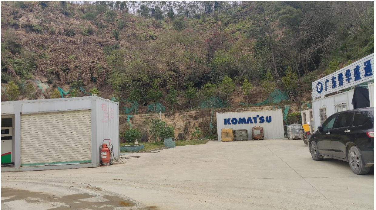
照片 4 临时加工厂现状（镜向 6°，2023.02）
