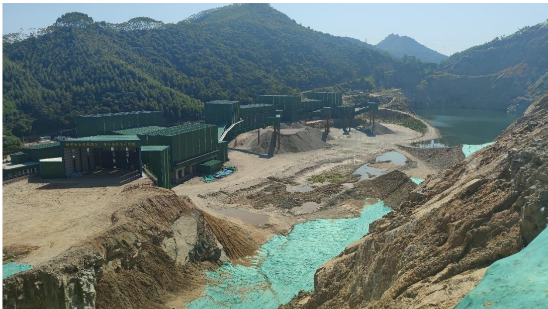
照片 1 破碎加工生产区域现状（镜向 65°，2023.02）
