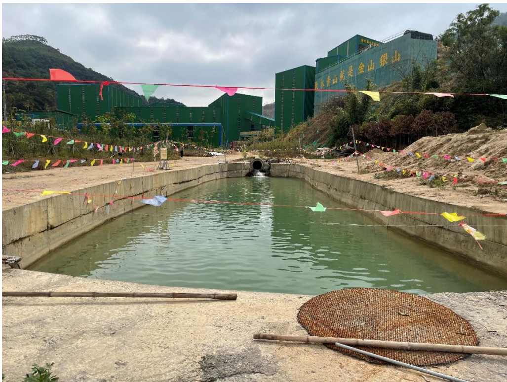
照片 3 沉沙池工程
