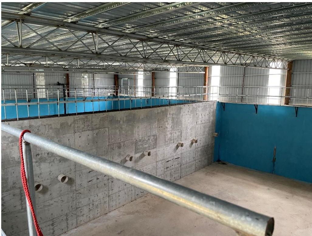
照片 2 沉砂池工程
