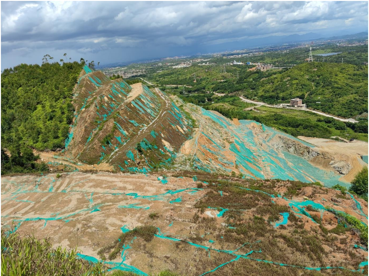
照片 5 露天采场台阶土地复垦措施（镜向 275°，2023.02）
