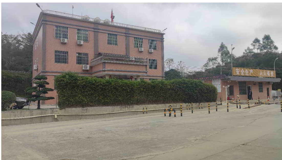
照片 2 综合服务区现状（镜向 356°，2023.02）
