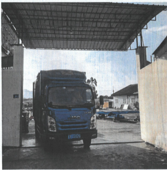
项目厂区大门
