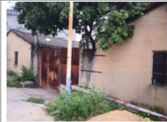
项目厂区 1 西侧空置厂房
