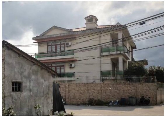
项目厂区 2 西侧隔道路居民楼
