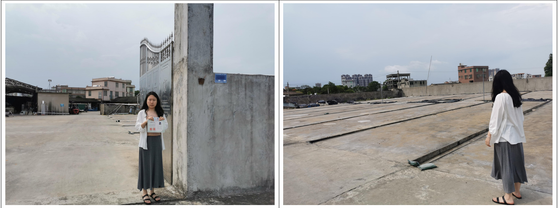
附图 12：工程师及踏勘现场照片
