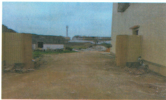
厂房一西南面隔道路为工厂（即厂房二东面）
