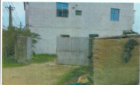
厂房三北面为工厂
