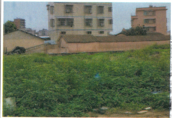
厂房一东南面为旧厂房和空地
