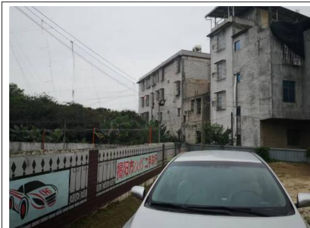
项目西侧零散民楼
