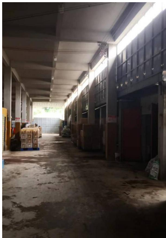
项目综合车间
