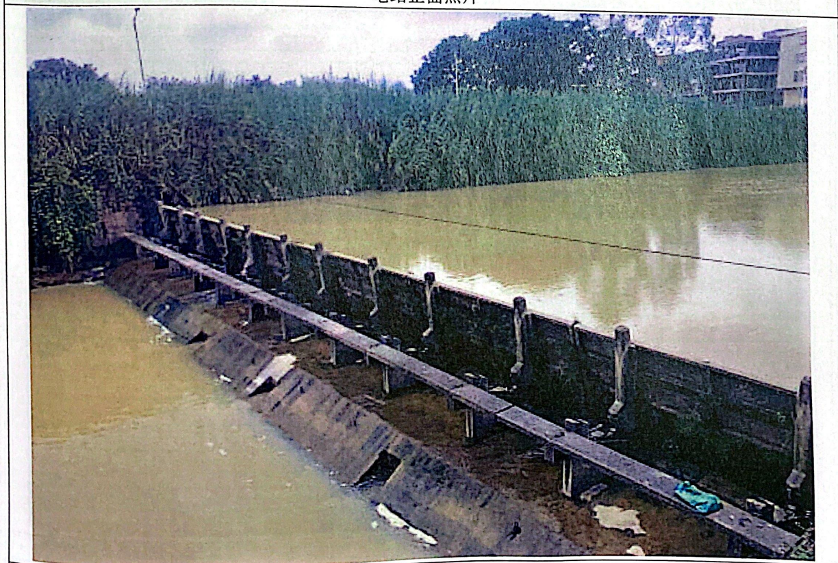
拦水大坝全貌
