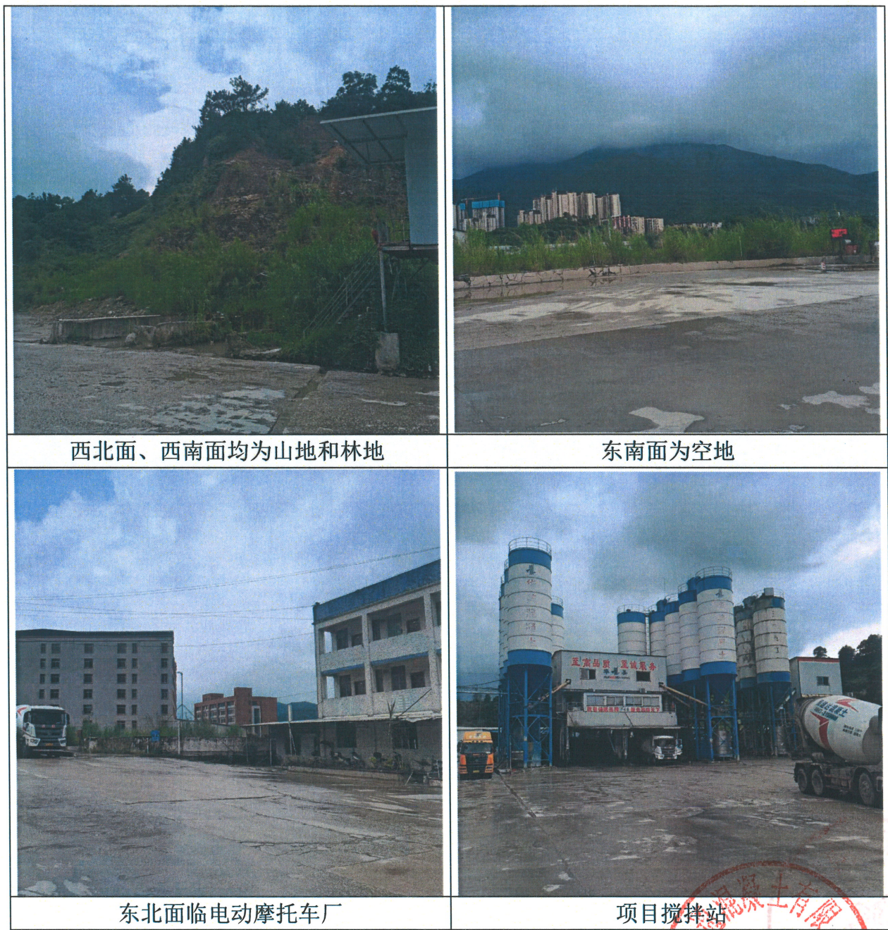
附图 5 项目四至及厂区现状照片
