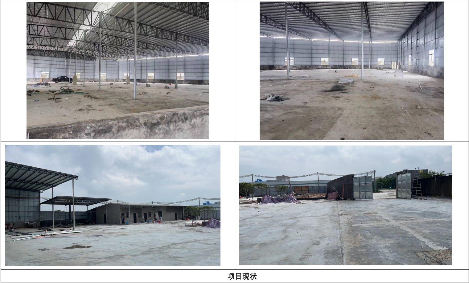
附图六 项目现状及现场勘察情况
