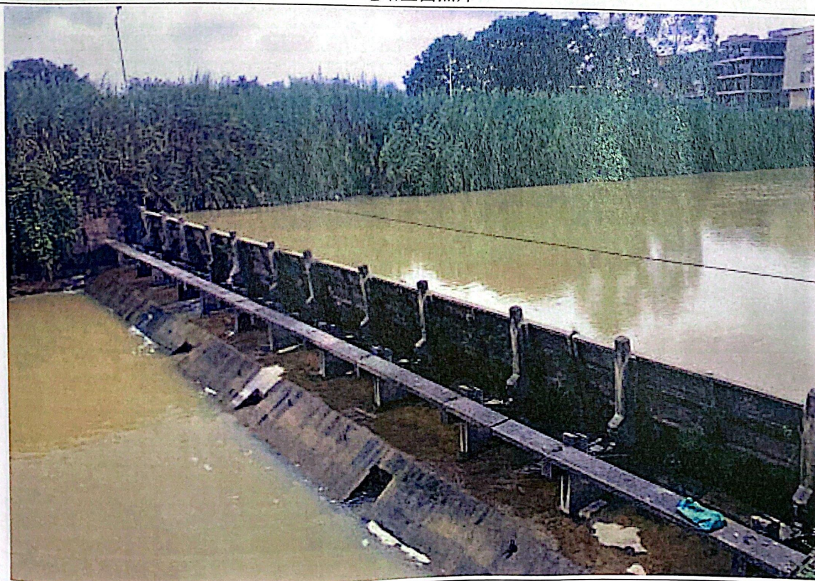
拦水大坝全貌
