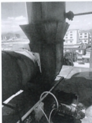
定型废气处理后检测口 (DA003) /Q4
