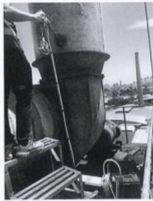
定型废气处理后检测口 (DA002) /Q3
