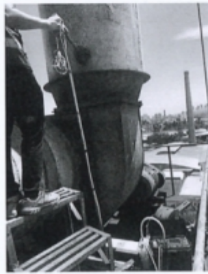
定型废气处理后检测口 (DA002) /Q3
