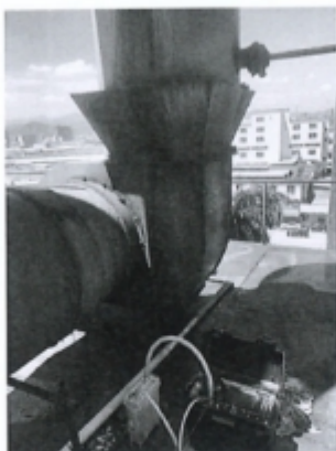
定型废气处理后检测口 (DA003) /Q4
