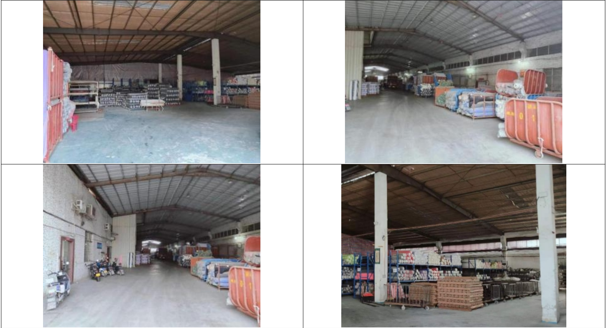
附图 16 项目车间现状照片
