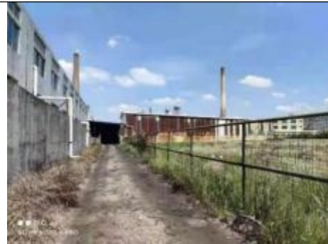
项目南侧-荒地
