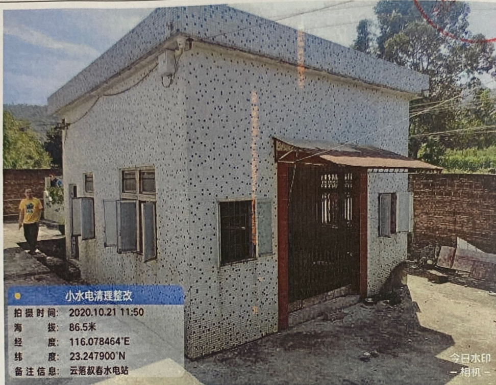
电站正面照片
