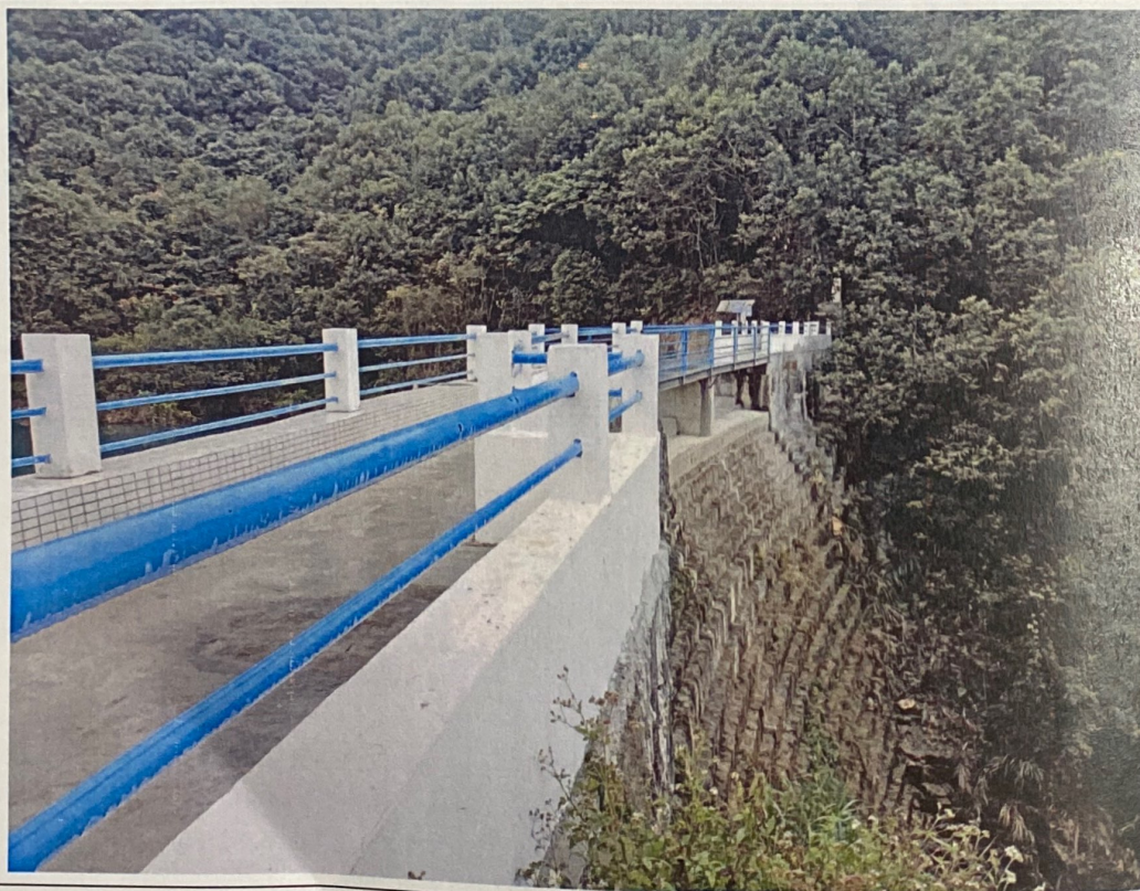
拦水大坝全貌
