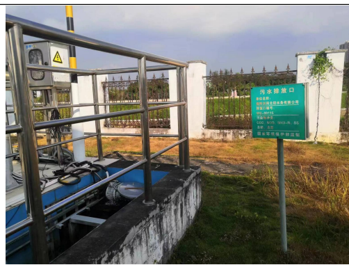
污水排放口标识化
