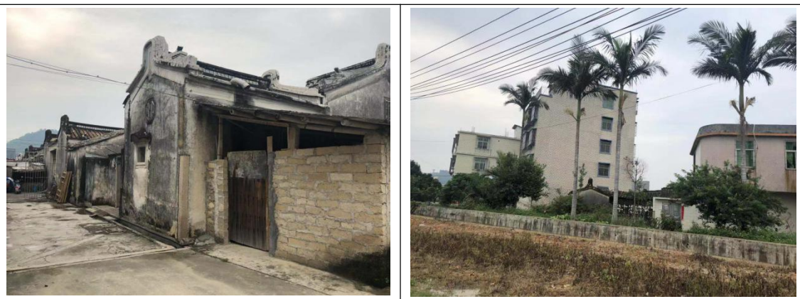
村内建筑现状
