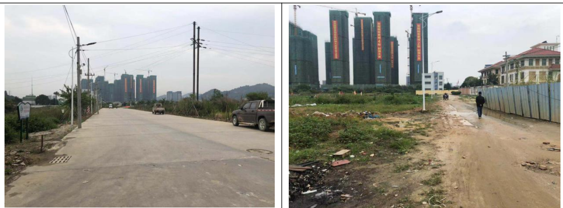
村内道路现状
