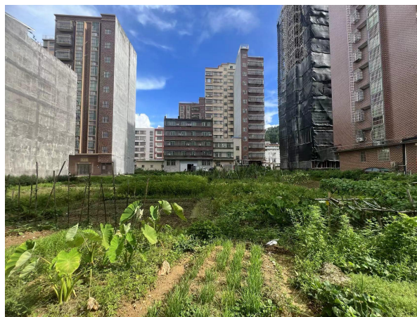
项目南面空地现状
