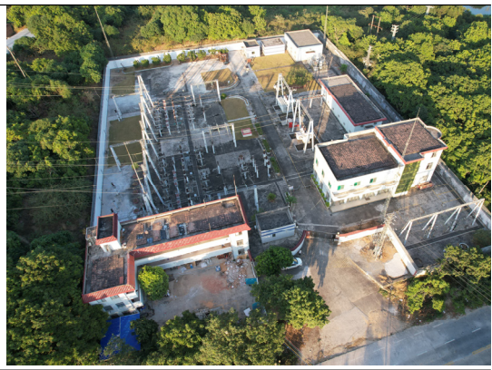
变电站航拍图
