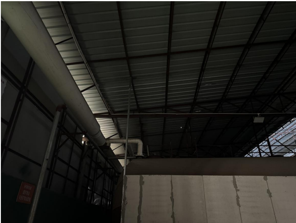
储罐区集气管道
