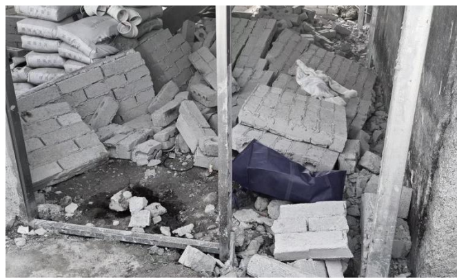
图 3 事故现场照片
