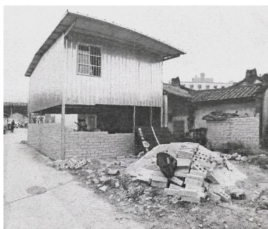
图 2 事故铁皮房照片
