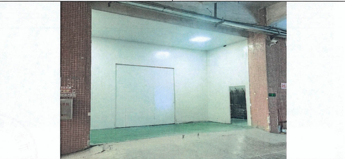
项目现场照片（大门）
