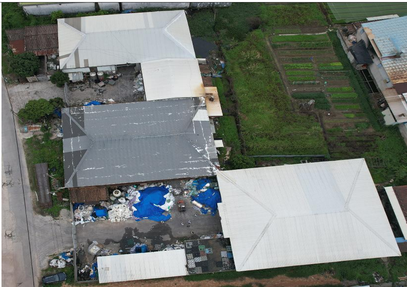
项目厂区俯视图
