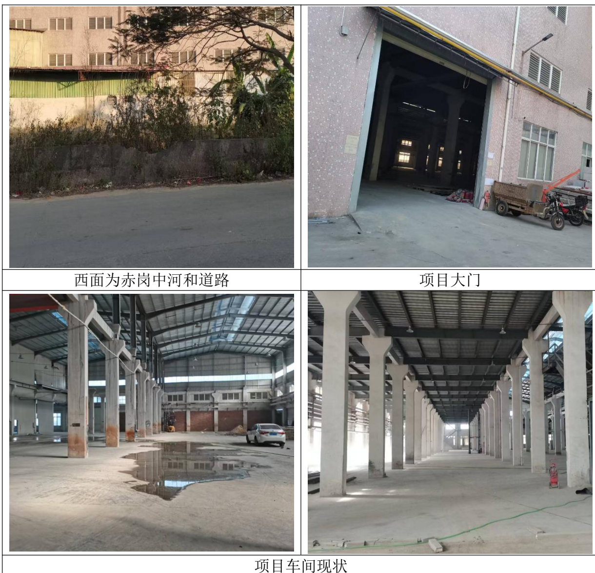
附图 4 项目四至情况及厂内现状照片
