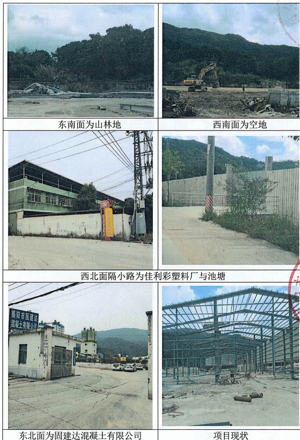
附图 5 项目厂区及四至现状照
