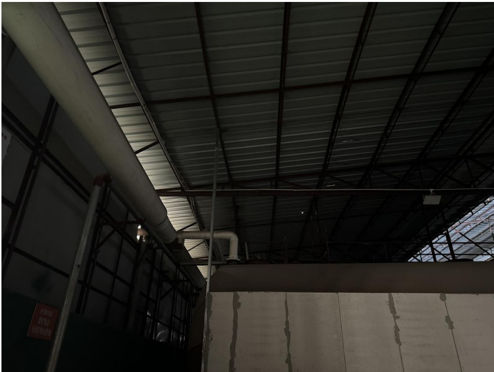
储罐区集气管道
