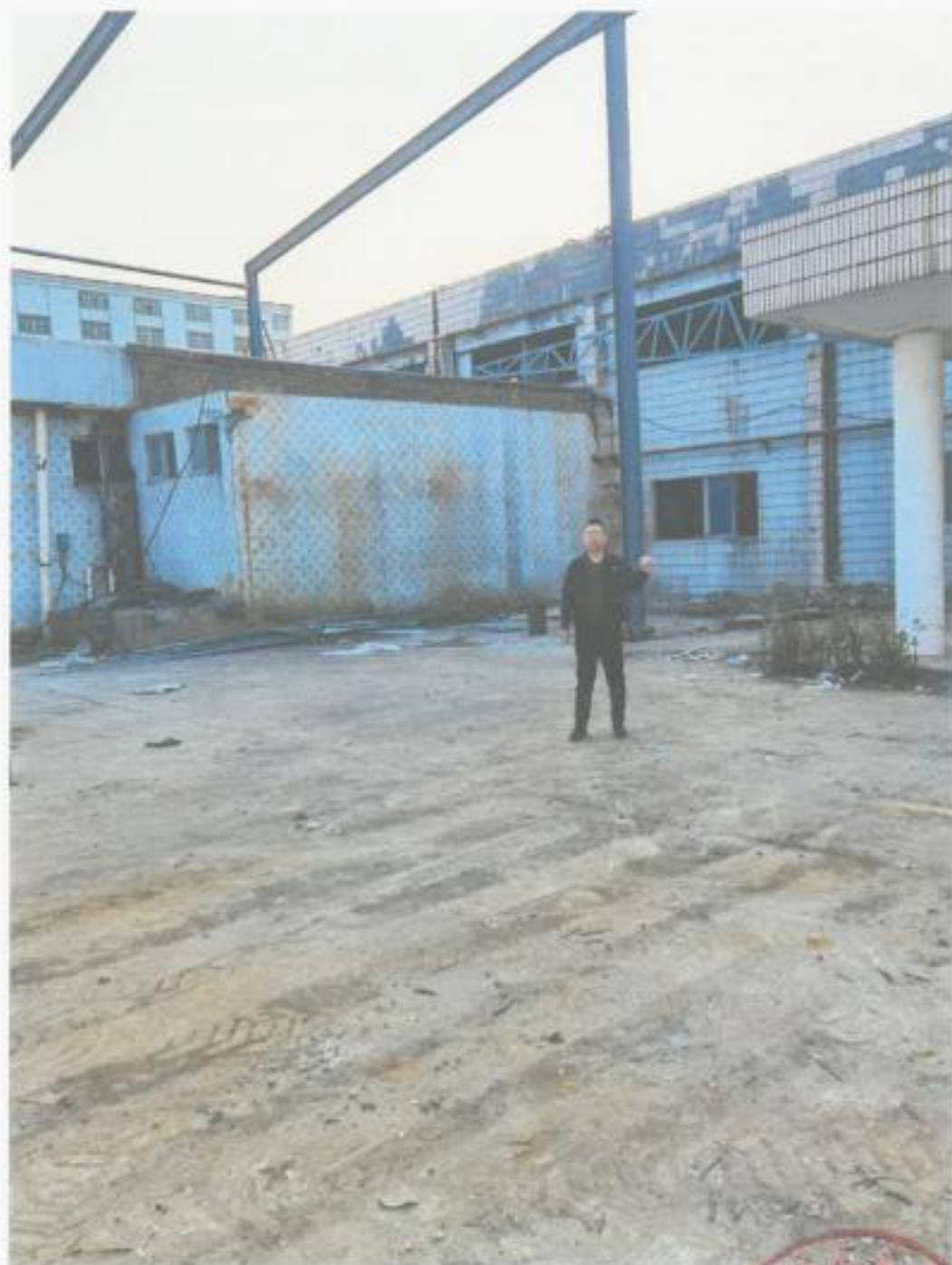
工程师现场勘查照片
