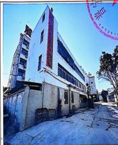
项目北面（普宁市顺益昌混凝土有限公司）
