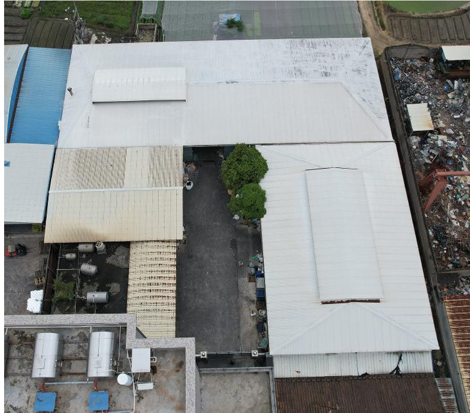
项目厂区俯视图
