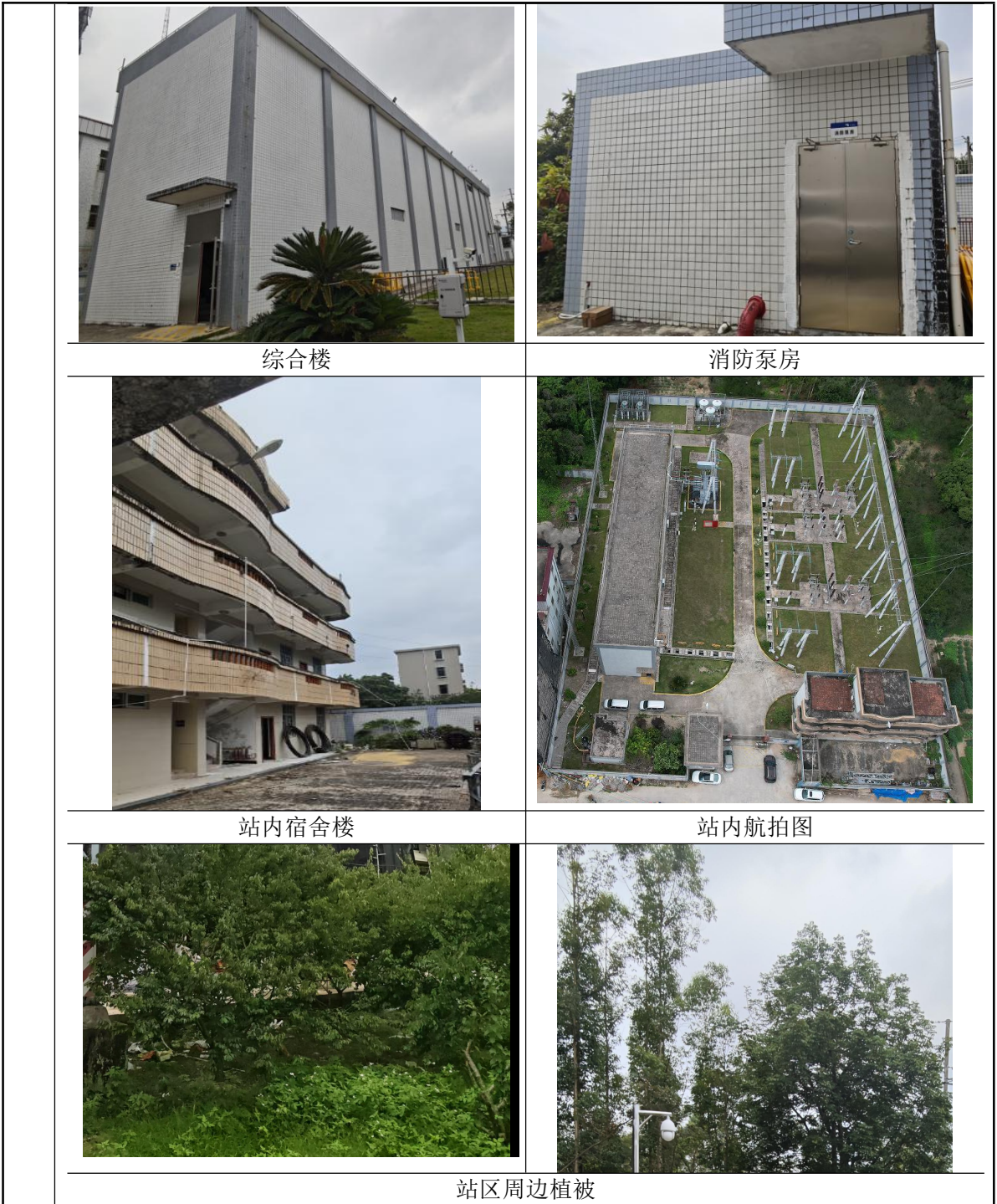
图 3-1 现状 110 千伏大坪站及周围环境
