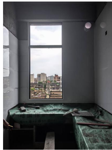
图 2：事故现场照片
