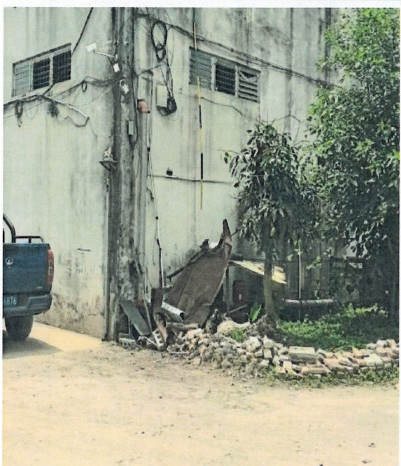
北面隔道路为工厂
