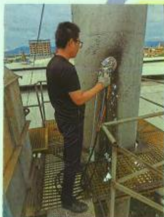
工艺废气排放口 DA003
