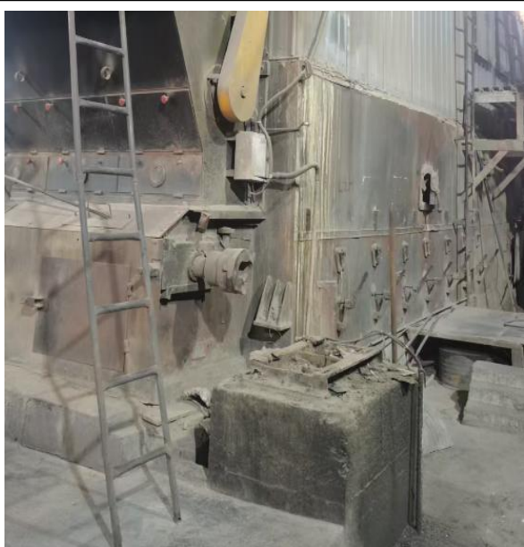
燃煤锅炉炉体现状（炉排动力装置、进出管道均已拆除）
