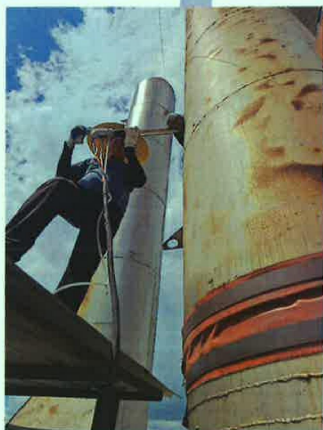
DA002 1#定型废气排放口
