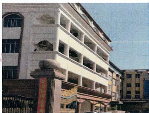
西面为厂区共用宿舍楼
