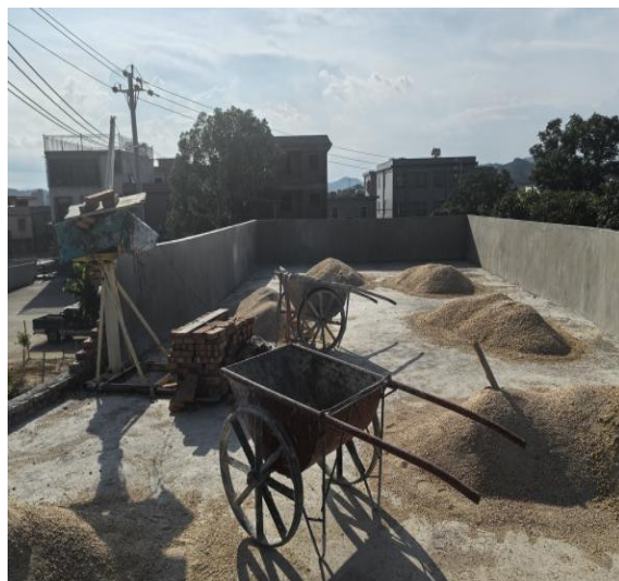
图 2 事故楼房 2 层照片
