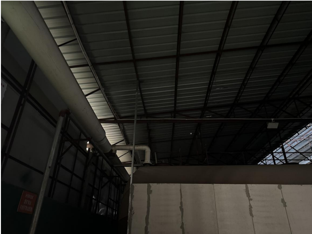
储罐区集气管道
