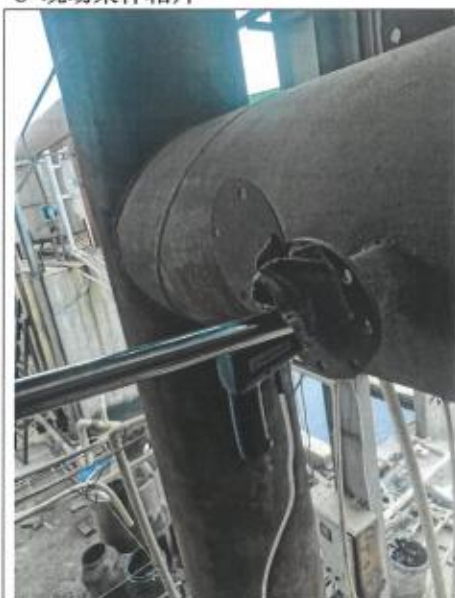
图 8.1 锅炉废气检测口 Q1
