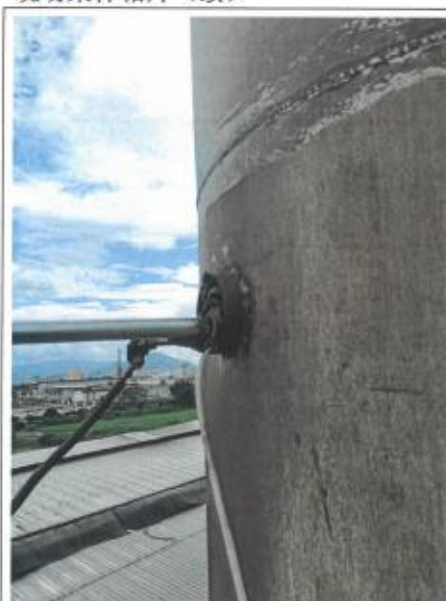
图 8.5 定型废气 4#处理后检测口 Q5
