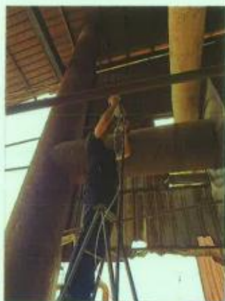
DA006 锅炉废气采样口
