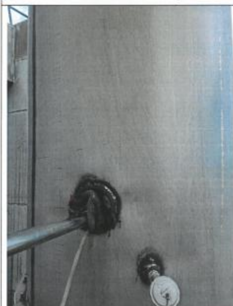
图 8.3 定型废气 2#处理后检测口 Q3
