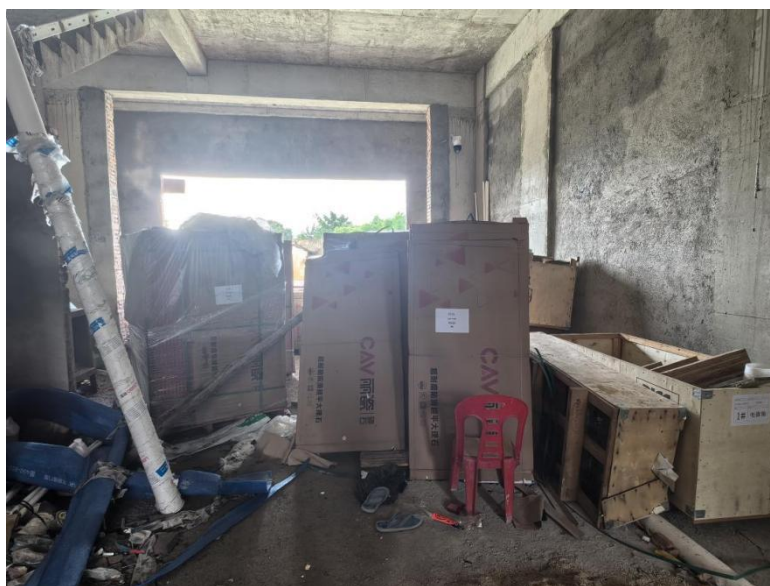
图 1：事故现场照片
