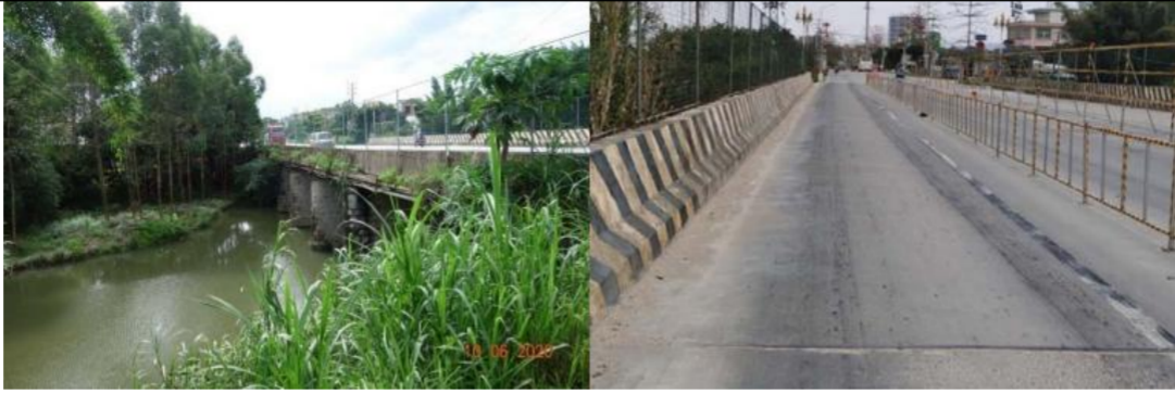
图 2-2 寨洋桥-2 旧桥现场照片
