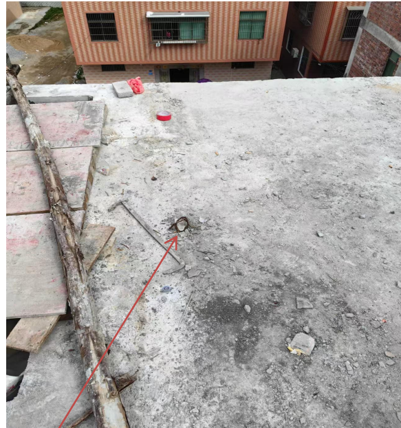
图二 原简易提升机天台楼板面安装位置情况
