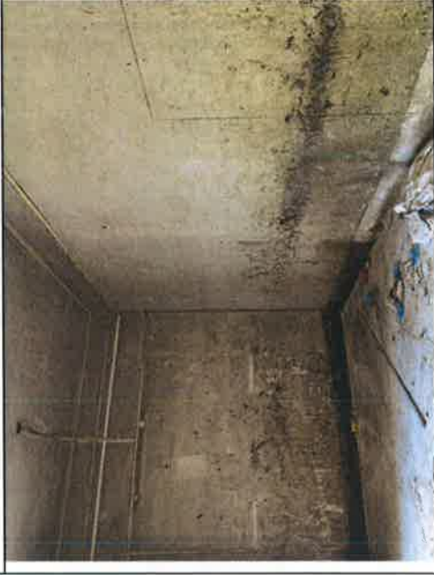
厂区现场照片
