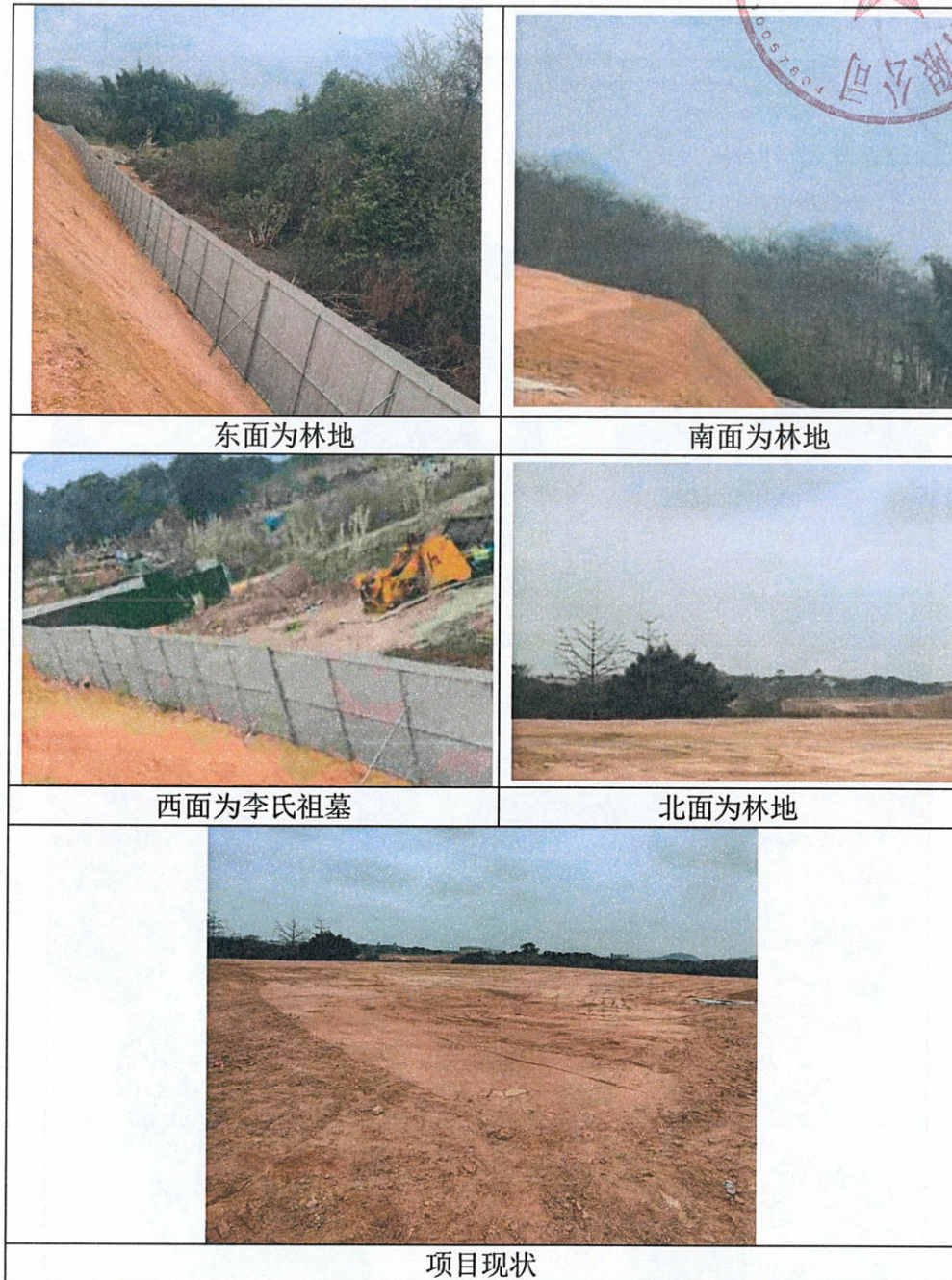
附图 5 项目厂区及四至现状照
