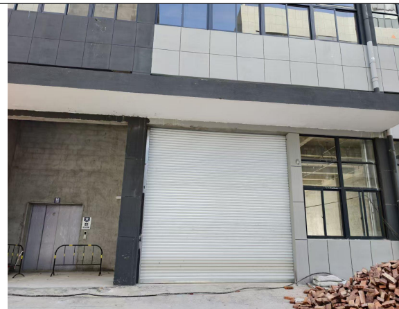
项目厂房门口现状
