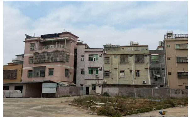
西面（龙堀村居民楼）
