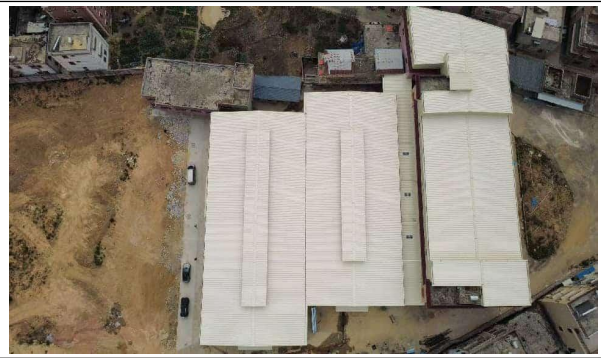
6号楼（注塑车间 1、2）
