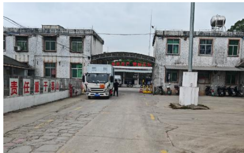
南侧液化石油气加气站
