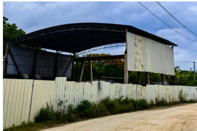
西侧个体户石材厂
