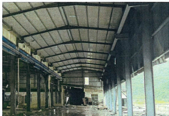
项目东北面为空置厂房
