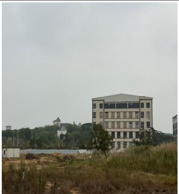
项目北面（空地）
