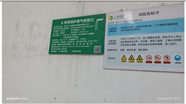
4号焚烧炉废气排放口环保标识牌
