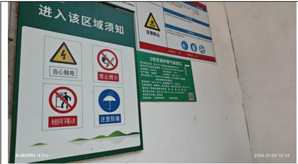
3号焚烧炉废气排放口环保标识牌
