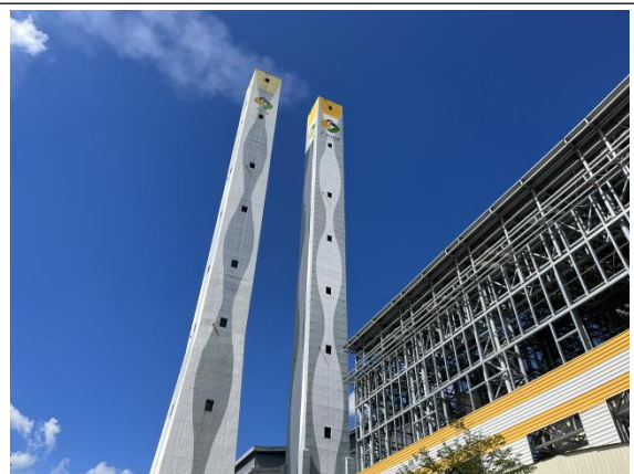
焚烧废气烟囱（右侧）
