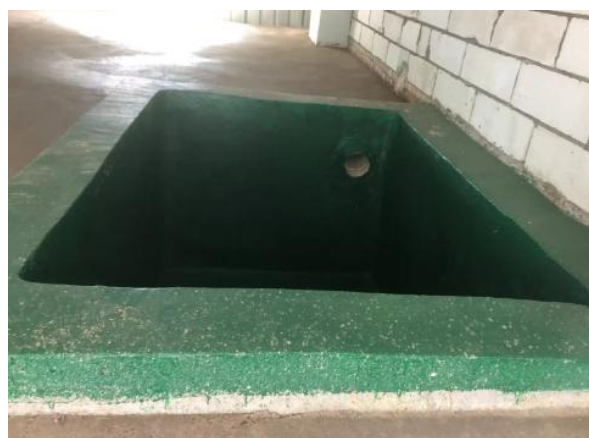
危废间收集井
